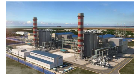
〈Jawa Satu Power Plant〉
